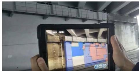
作成した3Dモデルを躯体に照らし合わせて、変状
