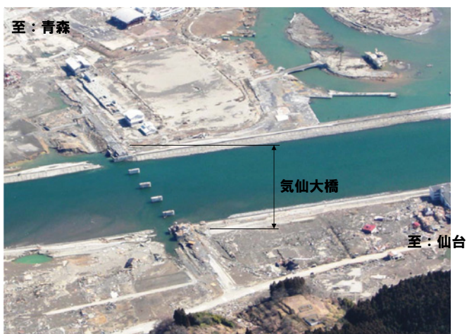
津波により橋梁上部工が流出(岩手県陸前高田市気仙大橋)
