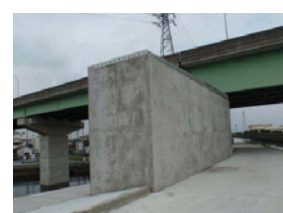
橋脚巻立て(アラミド繊維シート)
