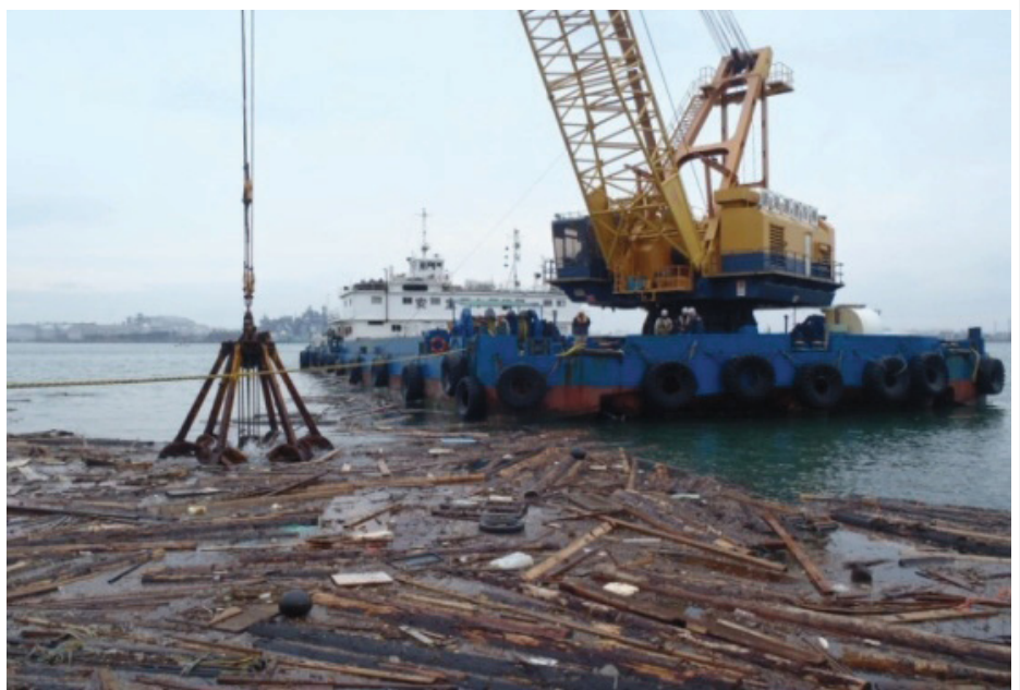
▲石巻港 流出した木材の除去
