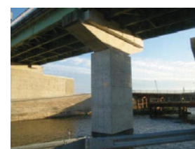
橋脚巻立て(RC巻立)
