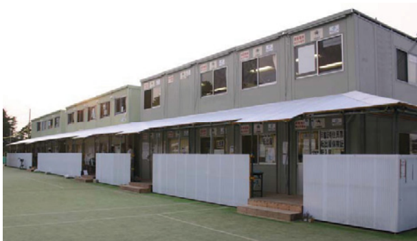
▲仮設ハウス(南三陸町仮庁舎)
