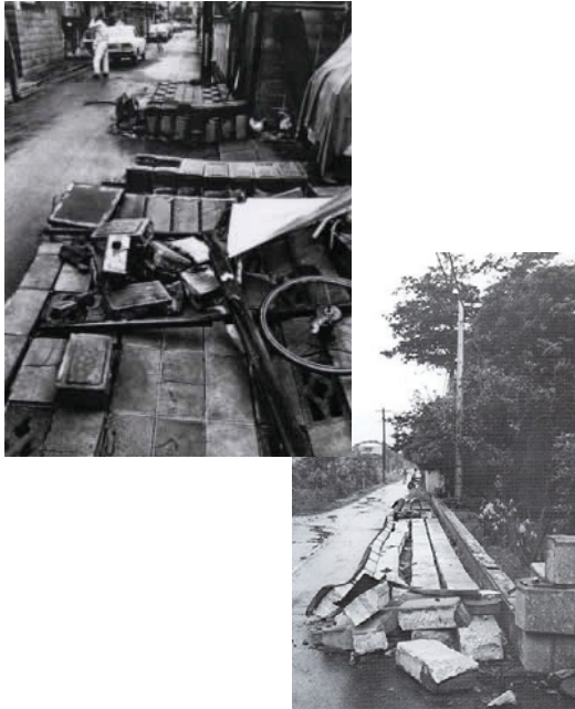
▼住宅地のブロック塀倒壊
