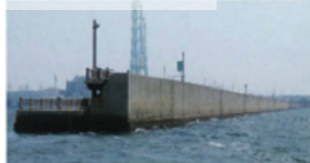
外港地区防波堤の現況
