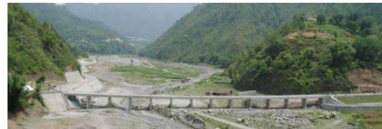
4. 流量が多く、かつ土石流の流れる河川では連続ボックスカルバートを適用し、越流を許容する沈下橋となっている。出典：日本工営 HP
