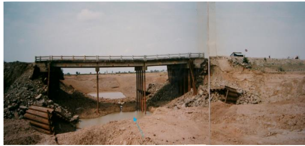
1993年の調査に基づき流失していたアプローチ部の再建のみを行った橋梁。今回は橋梁部の洗堀被害を受けた。写真は1-11, 1-12ともに横倉による。
