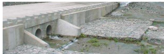
3. 乾季も常時流れの有る河道部では管渠を設けたコースズウェイが採用された。出典：日本工営 HP
