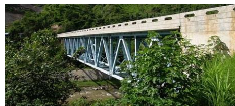
2. 谷地形では一般的な橋梁形式も採用。ロシ川を渡るロシ橋（スパン 83m の上路トラス橋）。出典：JICA ODA 見える化サイト。
