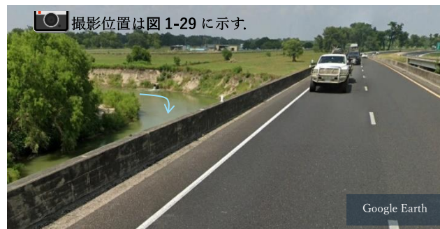
図 1-30 グアダループ川橋梁から見た左岸の洗堀状況
