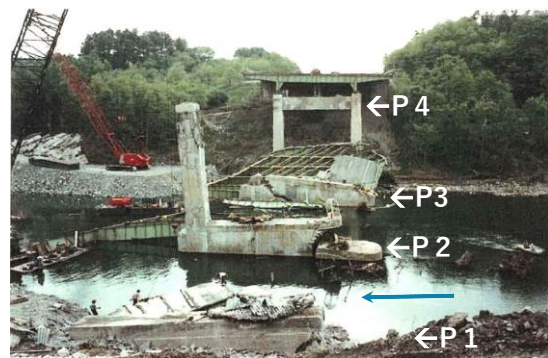
P2, P3 の台座 (plinth) が破断しているのがわかる。傾いていた桁 1 は撤去済み。出典: ASCE Failure Case Studies: Lessons from the Collapse of the Schoharie Creek Bridge
