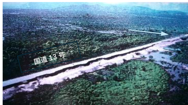
横断盛土部の下流側法面が洗堀されている。写真提供：細川容宏氏
