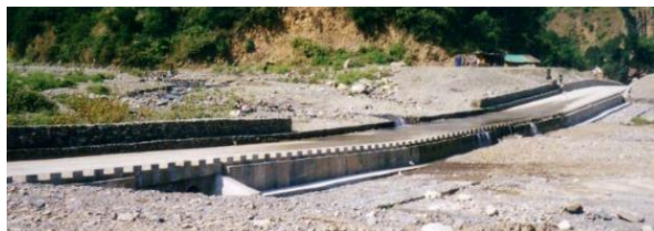
1. 緩勾配、堆積土砂撤去が容易な土砂流が主となる天井川状の支流では洗い越しが採用された。出典：日本工営 HP
