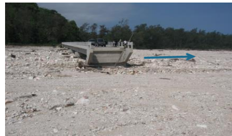
写真提供：JICA 国際協力専門員三部信雄氏 図 1-8 右岸側の取付け盛土が流失したファツアット橋
