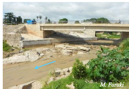
図3-13 洗堀により損傷した橋台基部の事例
