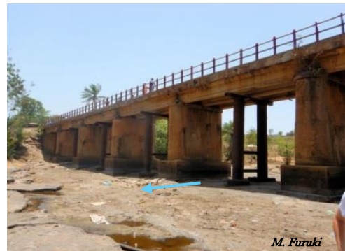
橋桁の中央を補助的橋脚で支えている。
