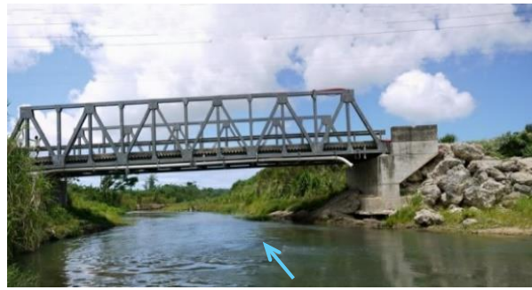
図 1-6 旧テオウマ橋右岸側橋台（基礎が露出）と橋台背面盛土の被災状況
