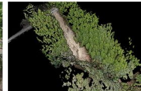
直高100mの被災現場をドローンで10分で計測
