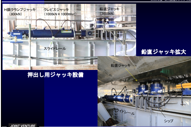
(6) 柱頭部押し出し用設備
