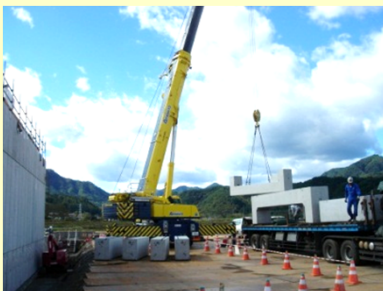
大型BOXカルバートのプレキャスト化
