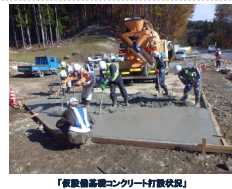
「仮設橋基礎コンクリート打設状況」
