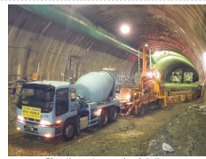
「宮内第1トンネルインバート打設状況」
