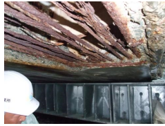
桁下面のPC鋼材の腐食、破断状況 硬化コンクリート中の空気量は約0%
