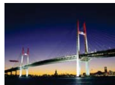
横浜ベイブリッジ（湾岸線）
