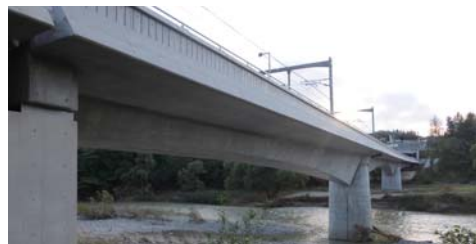
広瀬川橋りょう
