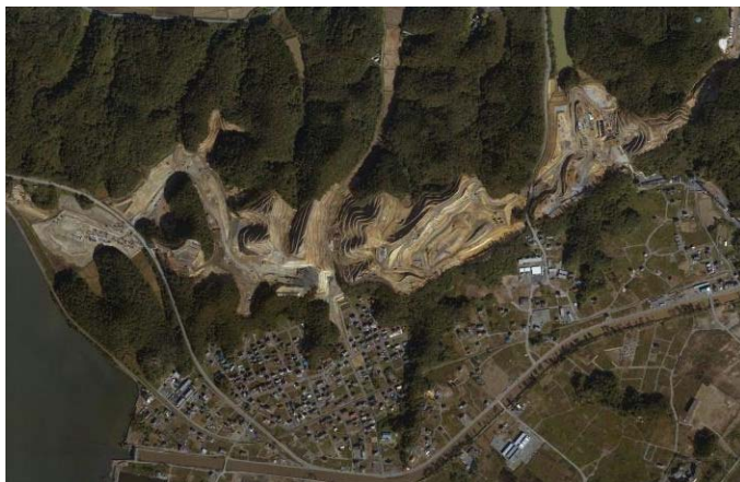
上空からみた造成状況
