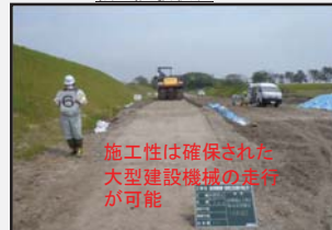
転圧試験状況
