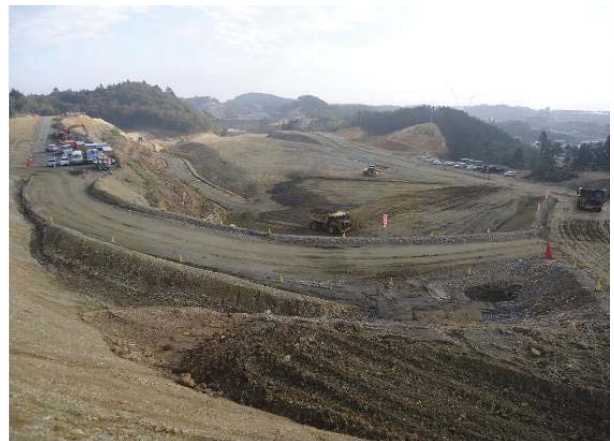
中工区付近の造成状況
