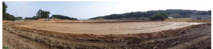
離半島部 出島地区の造成状況
