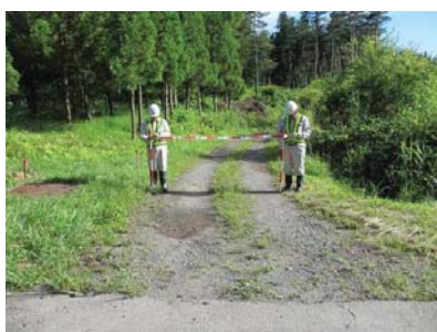
▲工事用道路調査
