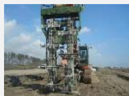
パワーブレンダー工法
