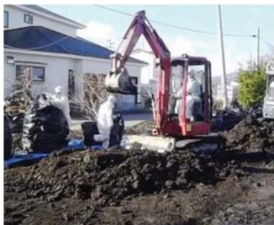
機械と人力による フレキシブルコンテナ詰め作業
