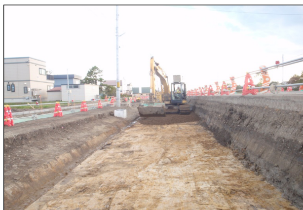
路床掘削・仕上げ
