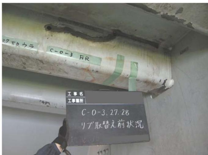
図 4-12 鋼床版のき裂の状況（イメージ）
