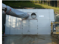
本坑 防音罩 コンクリート充填2層式
