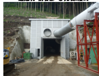
本坑 防音罩 コンクリート充填2層式
