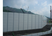
坑外ヤード 防音壁 H=4~8m
