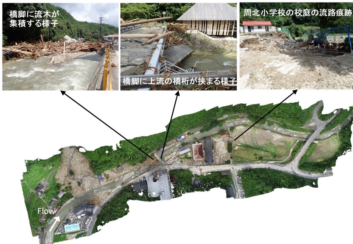
図 3-2-2-7 獺越地区の調査対象域のオルソ画像および被災状況
