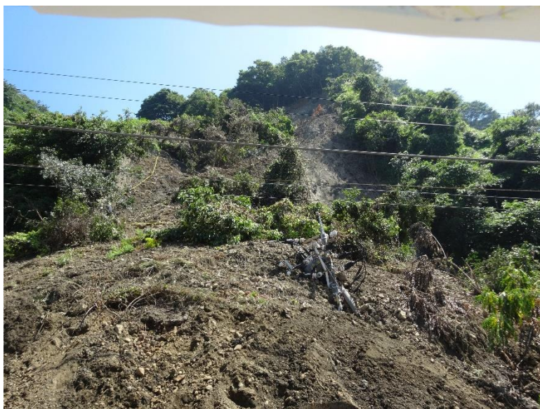
【JR 山陽本線斜面崩壊】
