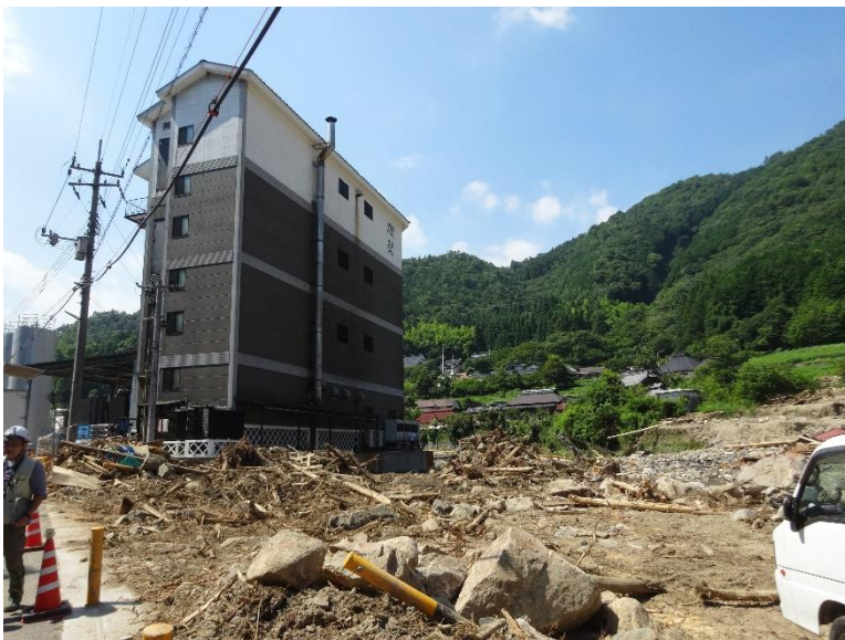
【瀬越地区土石流 1 堆積部その 2】
