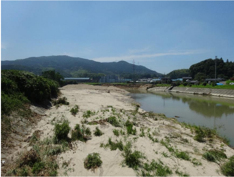
【島田川護岸崩壊】
