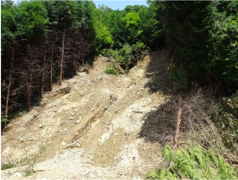
【道路沿いの斜面崩壊】
