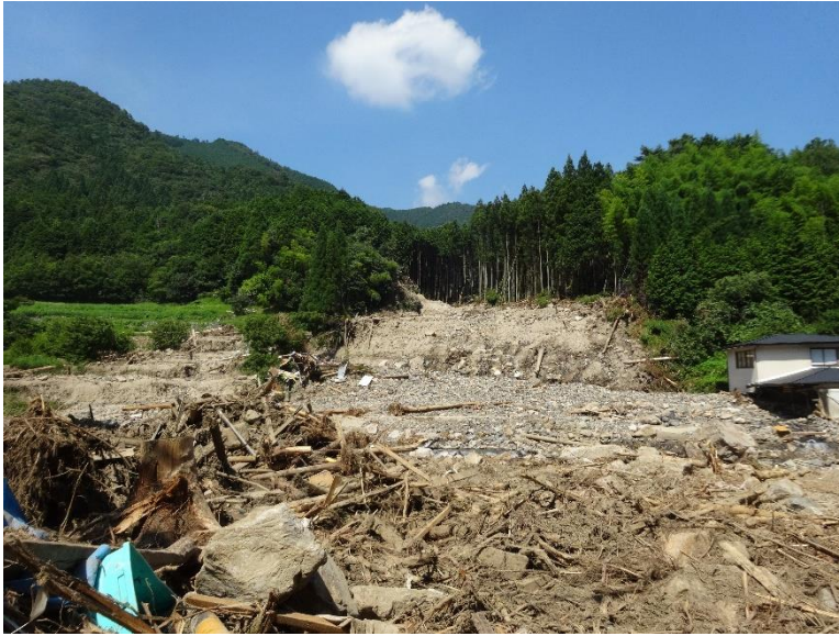
【瀬越地区土石流 1 堆積部その 1】
