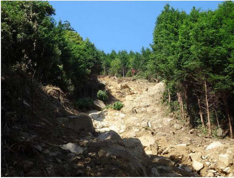
【瀬越地区土石流 2 源頭部】
