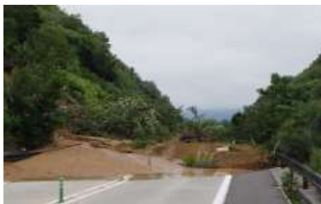
写真 東広島・呉道路自動車道の被害状況 (中国地方整備局)
