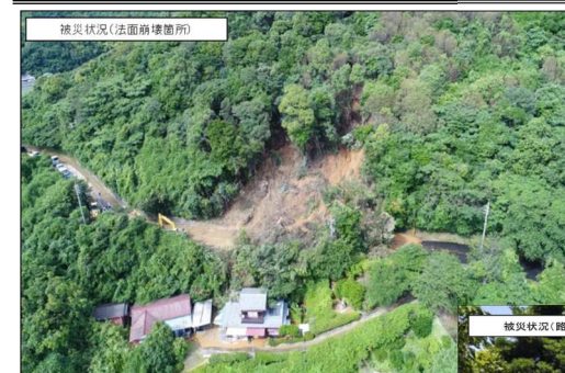
図3-3-2-5 一般県道173号笠戸島線尾郷地区①の被災状況(山口県道路整備課より情報提供)
