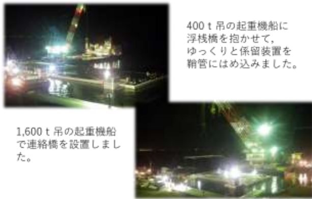
図-2 工事等報告(夜間施工)
