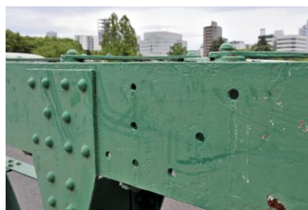
本川橋のリベット孔
