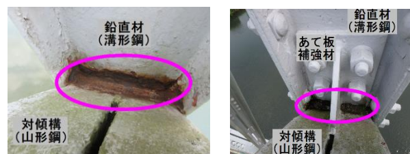
(a) 腐食減肉 (b) 土砂・滞水
