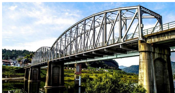
写真-1 対象橋梁
