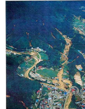
古野川の土砂状況(衛星写真)
