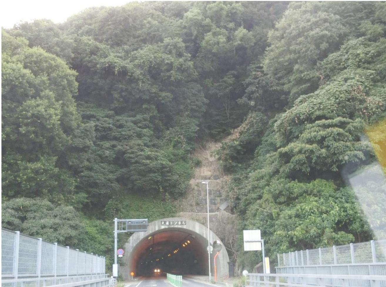
豊橋大橋側トンネル坑口で土砂が流出。
