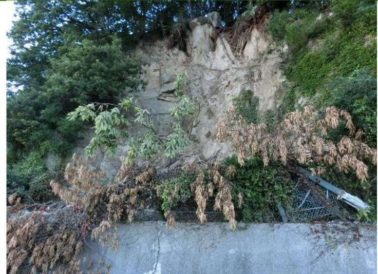
②岩盤崩落によりオーバーハングしている
