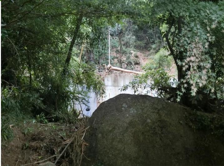
⑤砂防堰堤が土石流を捕捉したが、一部土砂が流下している（7/11撮影）
