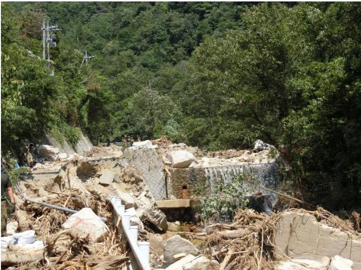
⑨道路が削られ、下水管が破断した（7/24撮影）
