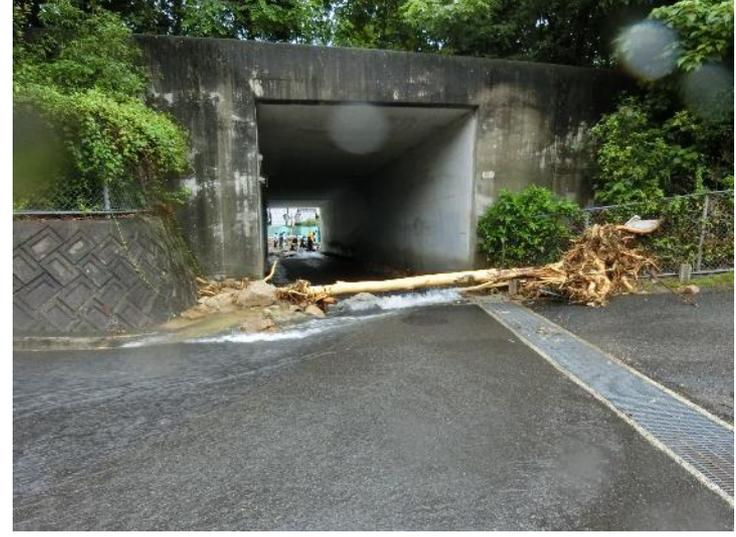
②側道に流下した土石流はボックスカルバートを通って下流の住宅街に流れ込んだ（7/8撮影）
