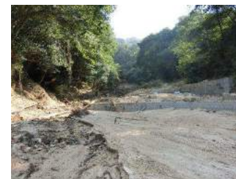
④ 深山の滝入口より焼山側の土石流
