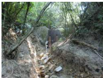
⑧堰堤の高さは約5m、幅12m
