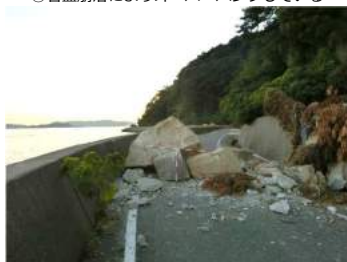
②直径2m程度の巨礫が落下している
