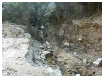
⑨合流点付近の渓流幅は4m程度、深さ1m程度 8/5撮影
