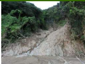
①土石流が道路に流下している
