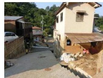
⑧団地内の道路を流下し、下流の家屋を破壊
