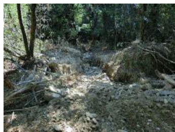
② 深山の滝入口から約150m天応側で呉環状線を再度横断
