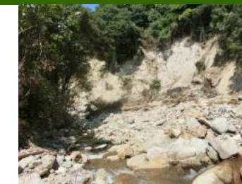
⑲右岸が削られ、大きく崩落している
