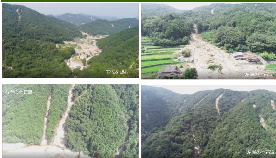
野呂川ダム上流の様子。野呂川兩岸の谷筋で土石流が発生している。
