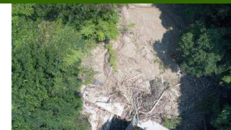
④ドローンで撮影。土石流が砂防堰堤で捕捉されている（7/16撮影）
