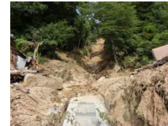
⑬左岸で発生した小規模な土石流が家屋を破壊した（7/11撮影）
