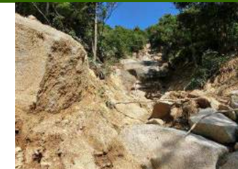
⑬渓流中間点あたりから上流を撮影（7/10撮影）
