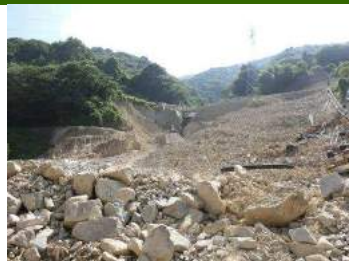
①国道375号線の橋が落橋。水道管も被害を受けた
