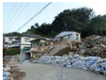
⑦巨石がある付近の2件が完全に破壊されている。
