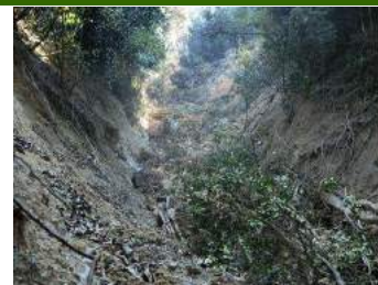
⑩上流左岸側で小規模な崩壊が起きている
