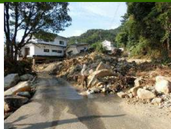
⑥道路下の水路が閉塞し、氾濫。団地内に土石流が流入
