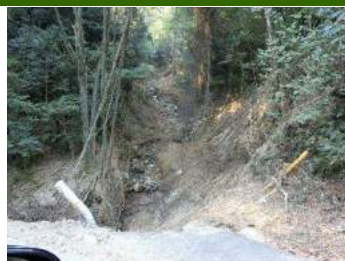
① 深山の滝入口から約200m焼山側で発生した土石流
