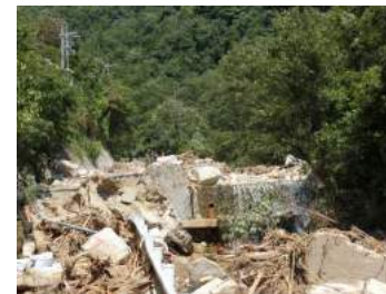
⑨道路が削られ、下水管が破断した（7/24撮影）
