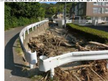
⑤橋部で流木で閉塞して、道路を流下した。（8/4撮影）
