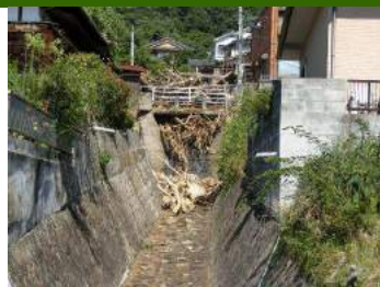
②流木が橋につまり、川を堰き止めた（7/15撮影）
