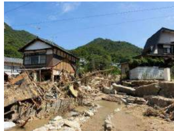
⑥ほぼ直線的な土石流が左岸側で発生し、家屋を押し流した（7/12撮影）
