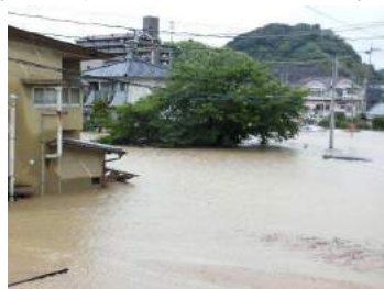
⑫広島呉道路高架付近では1階がほぼ水没している（7/8撮影）
