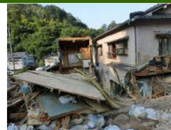
⑦土砂は道路を隔てた下流の家屋も破壊した。
