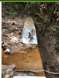
⑦堰堤はほぼ満砂状態である。
