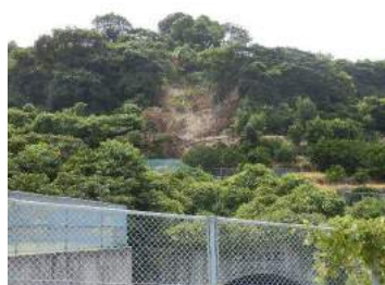
田戸トンネル坑口上部付近で発生したがけ崩れ
