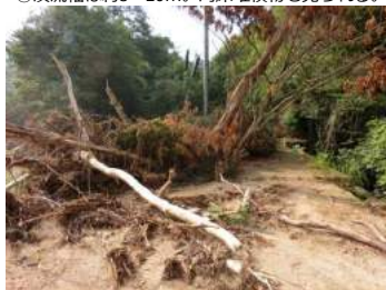
④土石流が橋を40cm程度押している。
