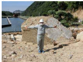
②水源地施設内にあった砂防堰堤と思われるコンクリート塊。
