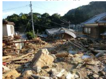
④流下した土石流が家屋を破壊した 7月9日撮影
