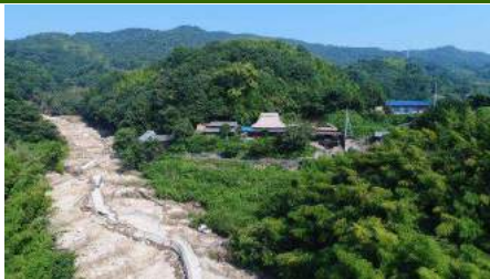
①ドローンを用いて撮影した上流の様子（7/16撮影）
