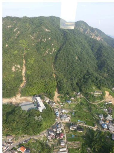
⑭ ヘリより撮影。画面中央の土石流。（7/13撮影）
