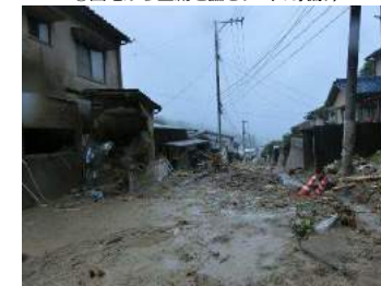
①団地内の道路を土砂が流下している（7/8撮影）
