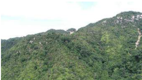
北側にも大規模な土石流が尾根直下から発生していると思われる
