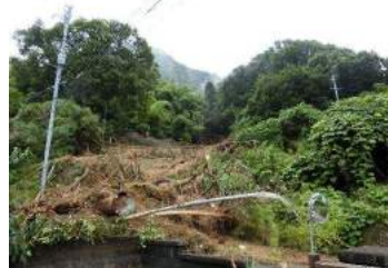
⑭ 土石流が天応中学校の通学路まで達している（7/18撮影）
