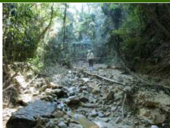
⑥堰堤により上流の渓流幅は5m程度
