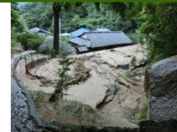
⑪流下した土砂が下流の家屋に流下した（7/11撮影）
