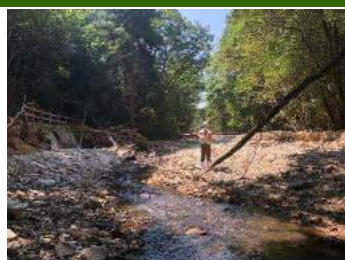
⑮滝から90m程度下流。河床から約1.2~1.5m堆砂
