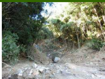
①溪流出口から上流を撮影。砂防堰堤あり
