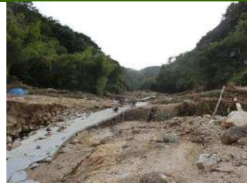
②住宅地上端付近から上流を撮影。勾配は緩い
