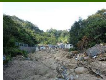
⑥下流を撮影。右岸にある家屋が破壊されている。
