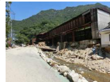
⑩工場にかかる橋が落橋し、河川を堰き止めている（7/24撮影）
