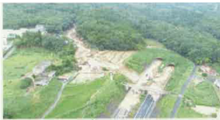
図3-4-1 山陽自動車道志和トンネルの東広島側入口付近で発生した土石流
