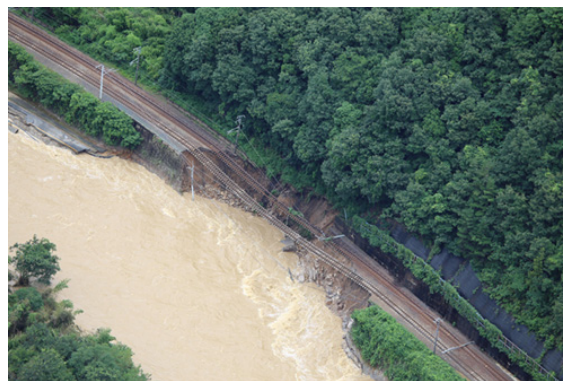
図 3-4-7 沼田川沿いの県道 33 号線および山陽本線の崩壊
