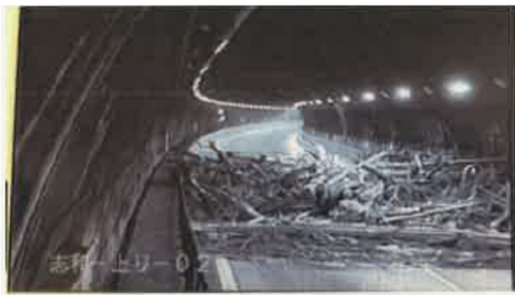
図3-4-2 山陽自動車道志和トンネル内を広島側出口付近の方向に移動する土砂と流木でできた「天然ダム」
