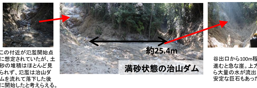
図-6 矢野東7丁目梅河ハイツの渓流に被害をもたらした渓流の状況
