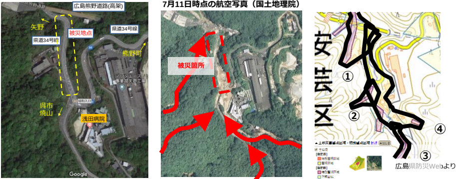
昭和入口交差点と被災箇所
