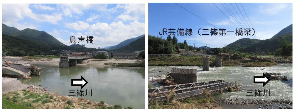
図7 道路橋、鉄道橋の落橋（三篠川）
