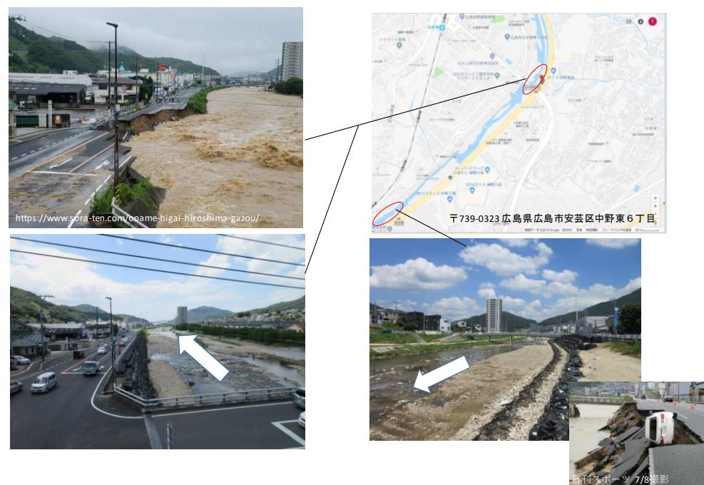
図6 河岸侵食による道路崩落、陥没被害（瀬野川と国道2号線）
