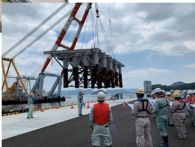
岸壁改良工事では、様々な土木技術を活用し、約2年という短期間で完成させた。その結果、令和5年にはコロナ後最多の58回(全国第6位、中国地方1位)のクルーズ船寄港を達成した。特にジャケット製作据付工事では、先行打設杭とレグとの位置関係を正確に把握し、据付精度を確保することが技術的に重要なポイントであったため、杭打設管理システム(パイルナビ)やCIMモデルを活用することで、精度の高い据付を実現した。さらに、シミュレーションを通じて手戻りを防ぎ、現場作業の省力化を図った。また、土木技術の伝承を目的として、現場見学会を実施し、次世代の技術者育成にも寄与した。
