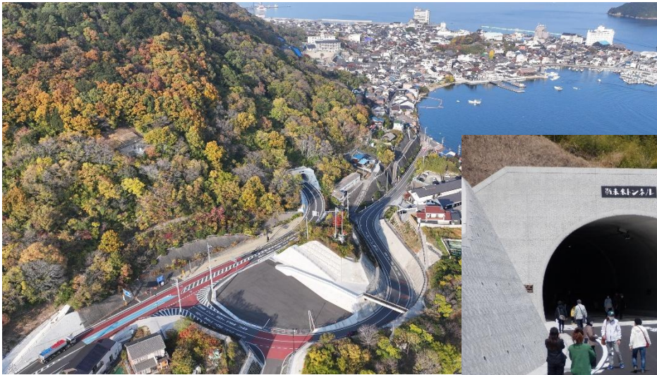
↑ 鞆松永線道路改良事業 鞆未来トンネル
