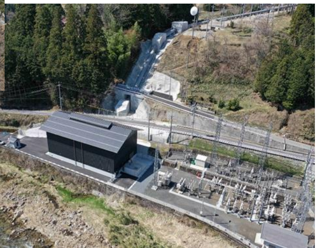
↓奥津発電所改修工事：発電所
