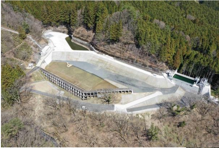
←奥津発電所改修工事：調整池
