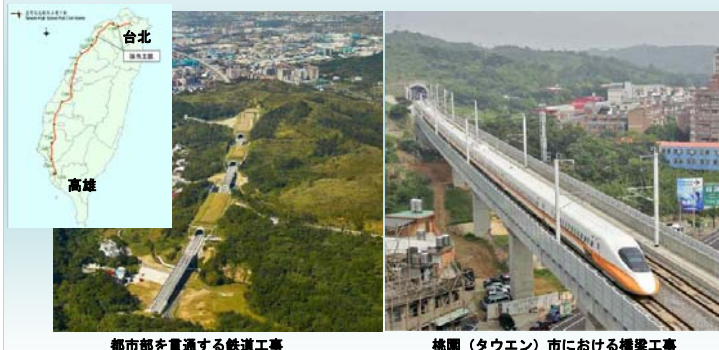
都市部を貫通する鉄道工事
