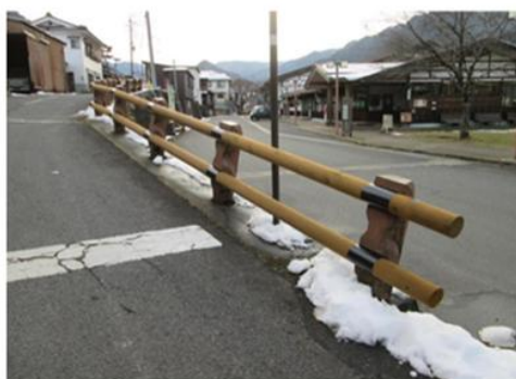
【道路事業】木製防護柵設置（長野県大桑村）
