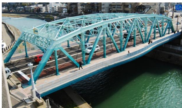
犀川大橋（国道157号金沢市） 1924年開通：102歳
