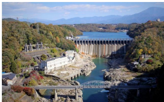
大井ダムならびに大井発電所（岐阜県） 1924年竣工：102歳
