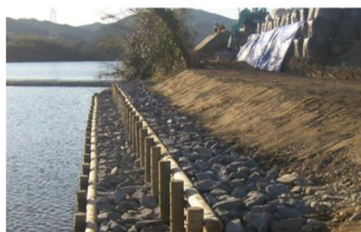
【河川事業】護岸工（宮崎県延岡市）
