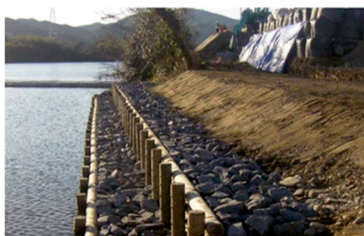
【河川事業】護岸工（宮崎県延岡市）
