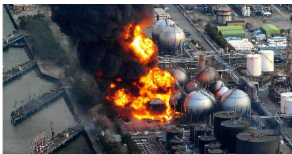
写真 2.2-6 球形貯槽の爆発・火災（2011年東北地方太平洋沖地震） 8),9)
