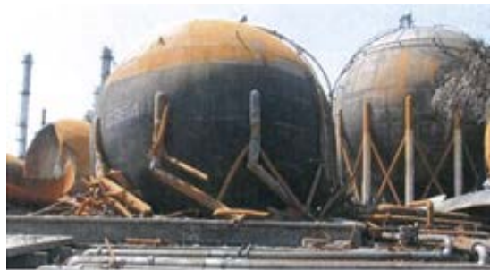
写真 2.2-6 球形貯槽の爆発・火災（2011年東北地方太平洋沖地震） 8),9)
