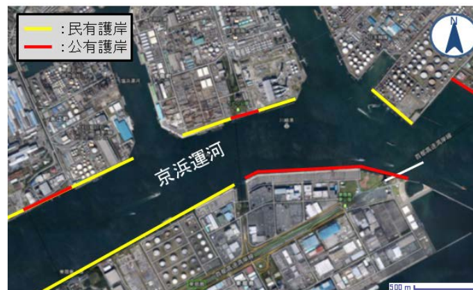
図.2 川崎港京浜運河（主要航路に面して公有護岸と私有護岸が混在している）
