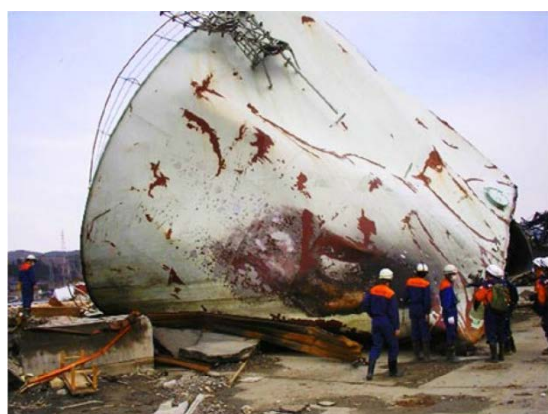
写真 2.2-2 津波により移動・倒壊したタンク（2011 年東北地方太平洋沖地震） 8)
