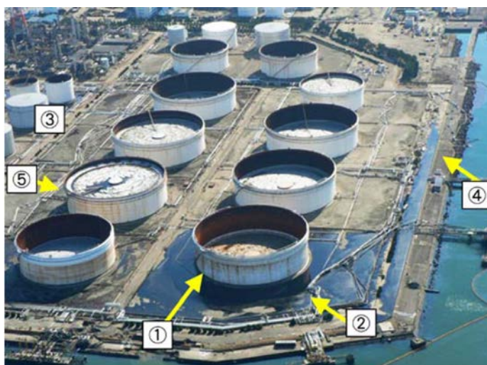
写真 2.2-1 危険物の漏洩状況（2011 年東北地方太平洋沖地震） 8)
