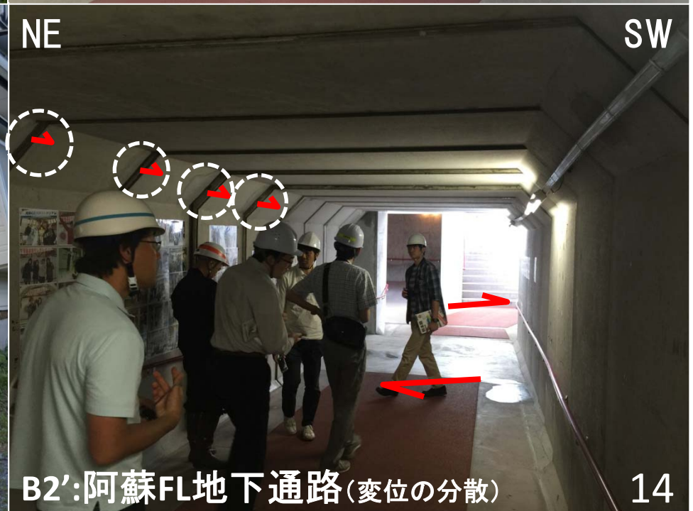
B2': 阿蘇FL地下通路 (変位を分散させた構造)
