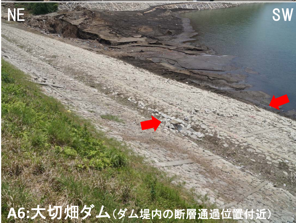
A6: 大切畑ダム (堤体を切る横ずれ断層)
