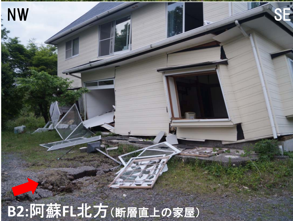
B2: 阿蘇FL北方 (横ずれ地表断層変位)
