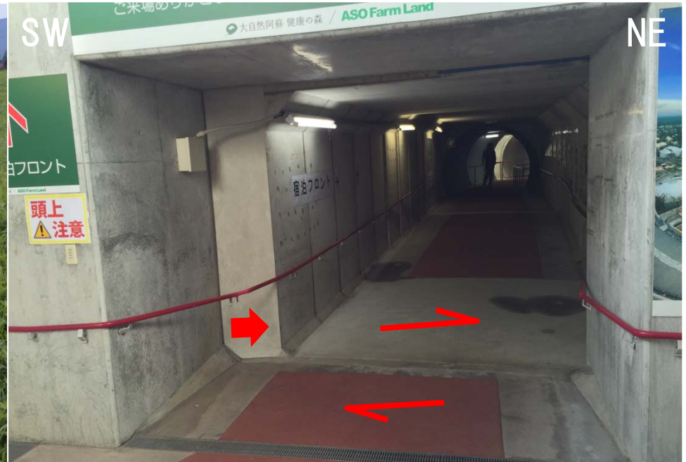
B2': 阿蘇FL地下通路 (変位を分散させた構造)
