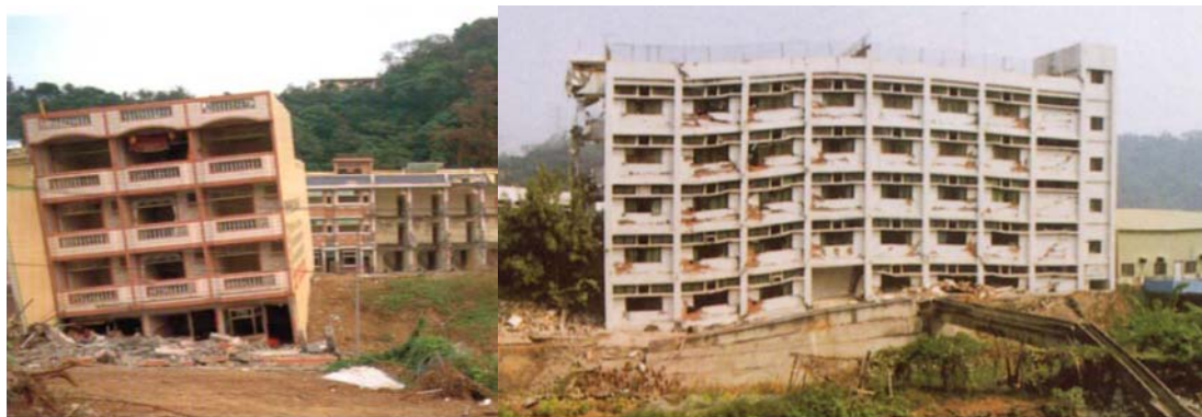
写真 2-1 RC 構造物の被害（左：剛基礎支持，右：柔基礎支持） 1)
