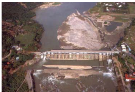
写真 2-3 断層により崩壊した石岡ダムのゲート 1)
