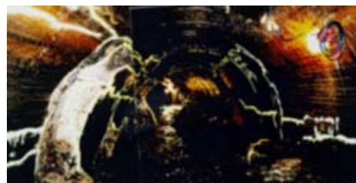
写真2-9 放水路トンネル被害状況 2)
