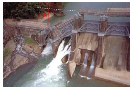
写真 2-3 断層により崩壊した石岡ダムのゲート 1)
