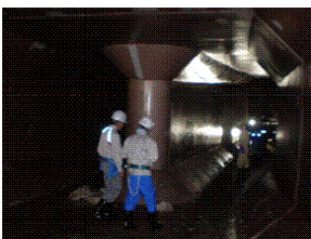
図-2.1.12 3号機取水路
