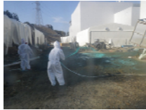
図-2.5.3 飛散防止剤散布の状況
