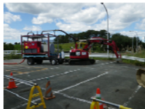
図-2.5.4 集塵機による集塵作業の状況
