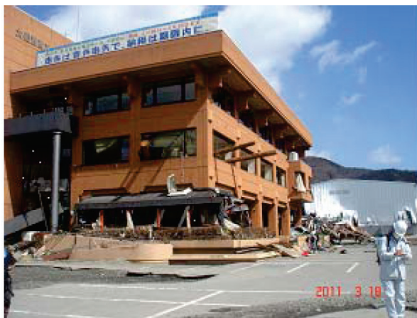
図 8.3.3-14 大船渡商工会議所（丸太が二階に侵入している）
