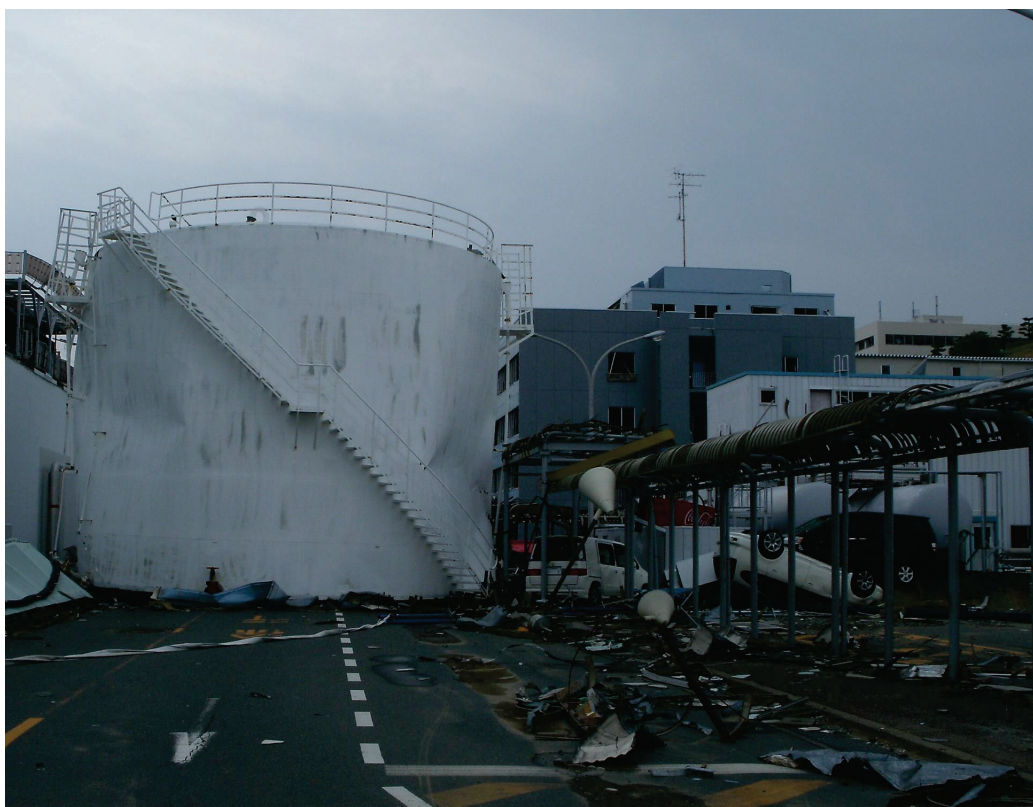
図 8.3.3-37 津波で流されて道をふさいだ重油タンク（福島第一） （直径 11.7m×高さ 9.2m）
