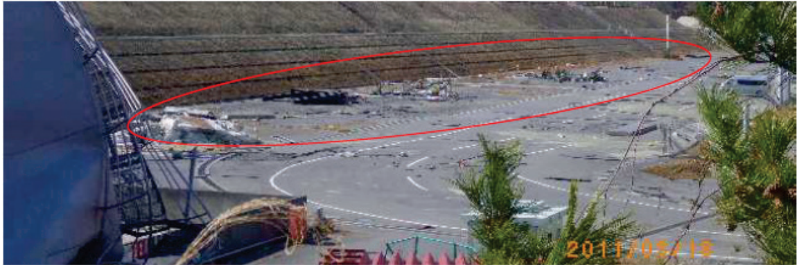
図 8.3.3-31 O.P. +2.5m*盤の漂流物状況（平成 23 年 3 月 18 日撮影） ※：地盤変動量約-1m を考慮した値
