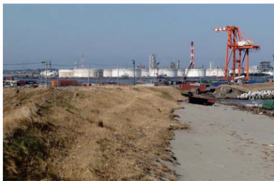
図 8.3.3-27 天端高さ 11m の海岸堤防を越流
