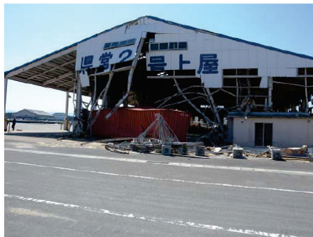
図 8.3.3-22 コンテナの衝突
