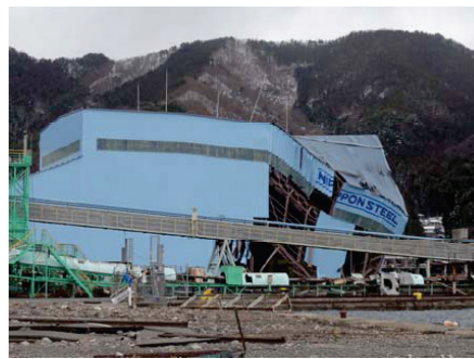
図 8.3.3-11 船舶が衝突した上屋
