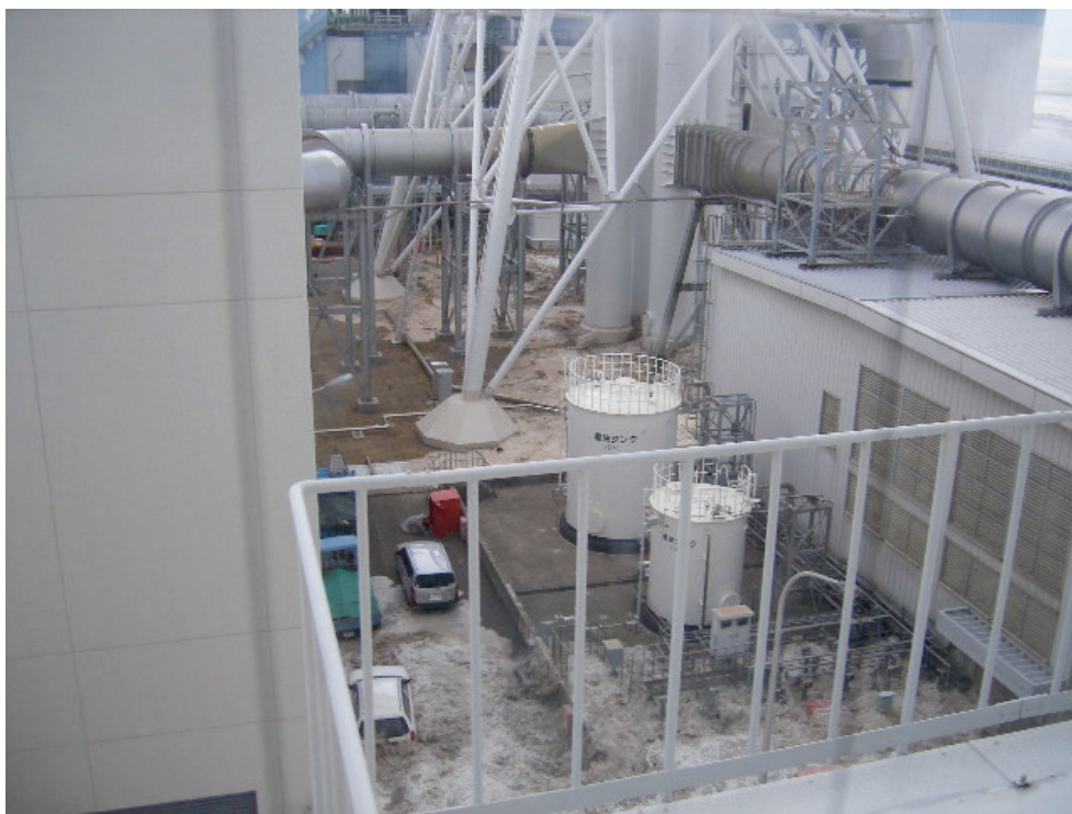
図 8.3.3-38 4号機南側集中環境施設プロセス主建屋付近の浸水直後の状況（福島第一） （敷地高：O.P.+10m, 重油タンク高さ約5.5m（写真中央））
