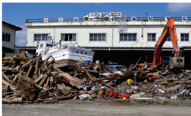
図 8.3.3-5 諏訪下地区の被災状況
