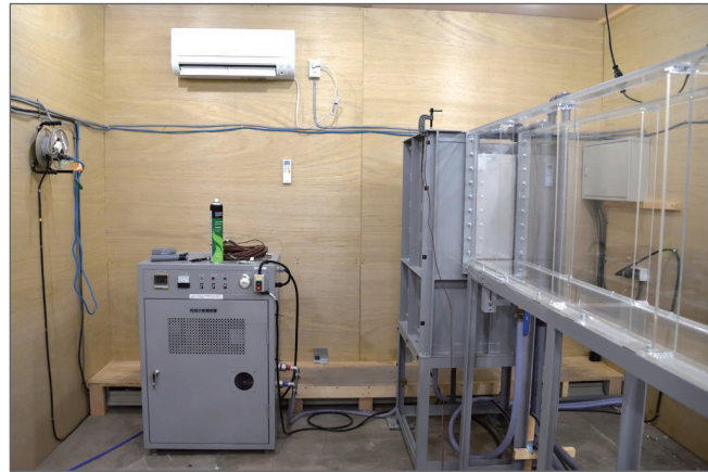
空調 (左上)、冷却水循環装置 (左) 恒温槽を貯水槽に接続 (右)
