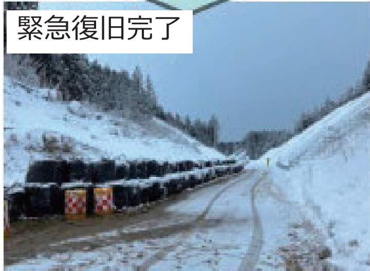
緊急復旧完了
