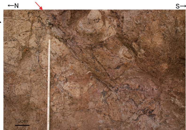
S-4 35m盤法面
