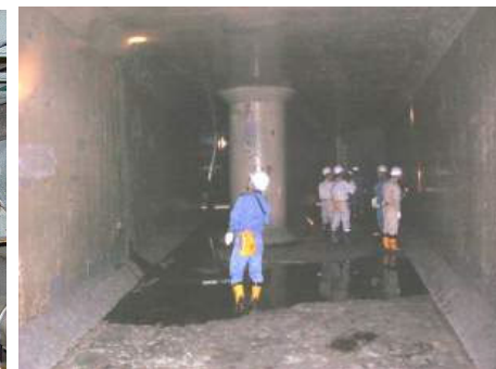
取水路(抜水時)
