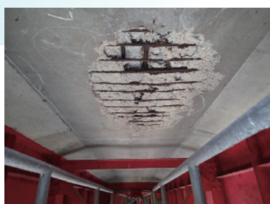
床版取替工事（左：施工前、右：施工後）
