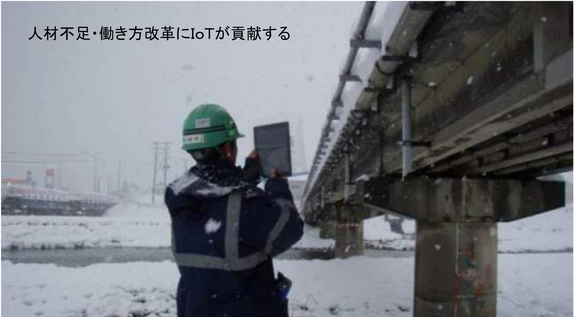
写真 タブレット端末を用いた橋梁点検調査
