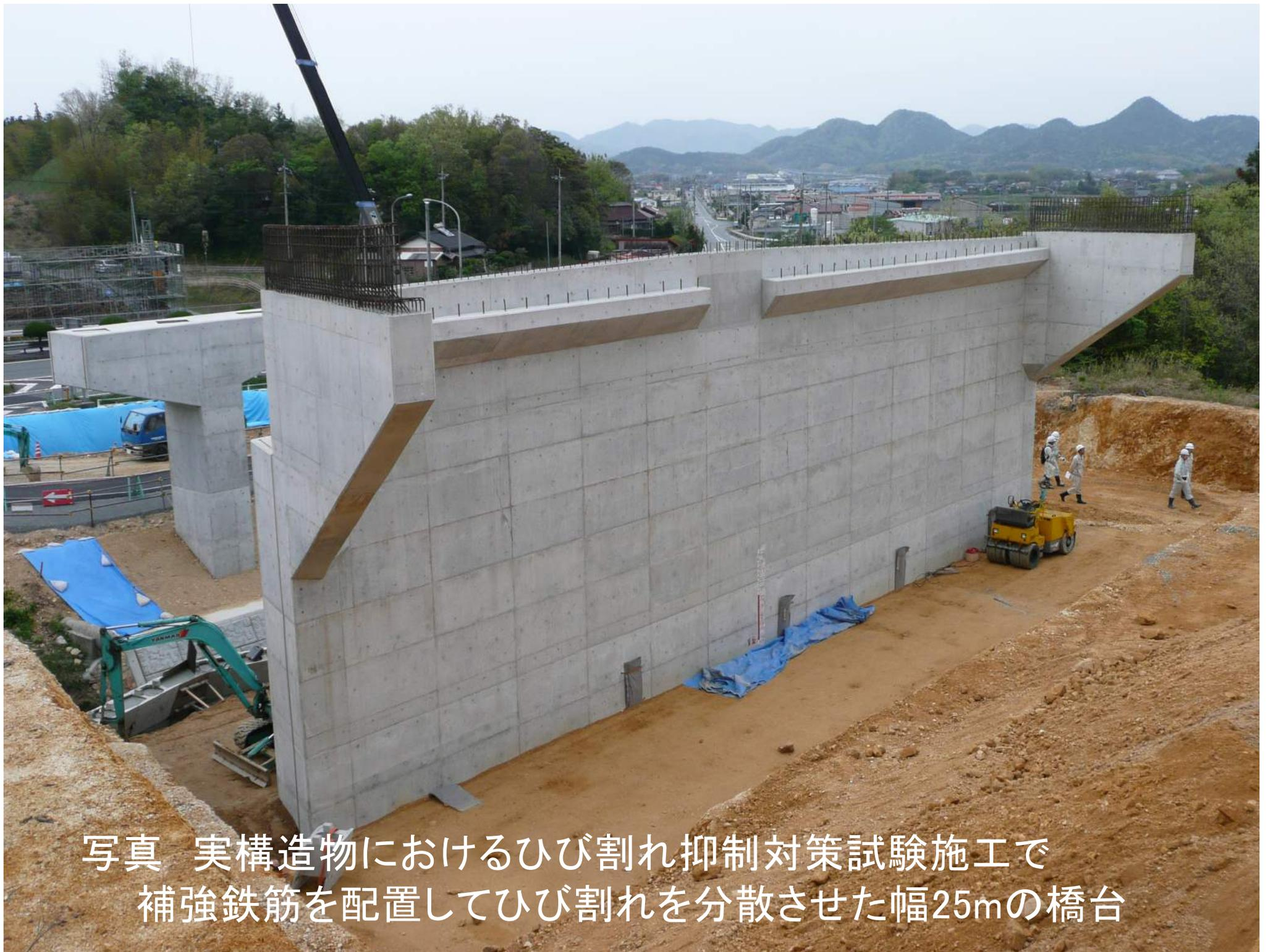
写真 実構造物におけるひび割れ抑制対策試験施工で
