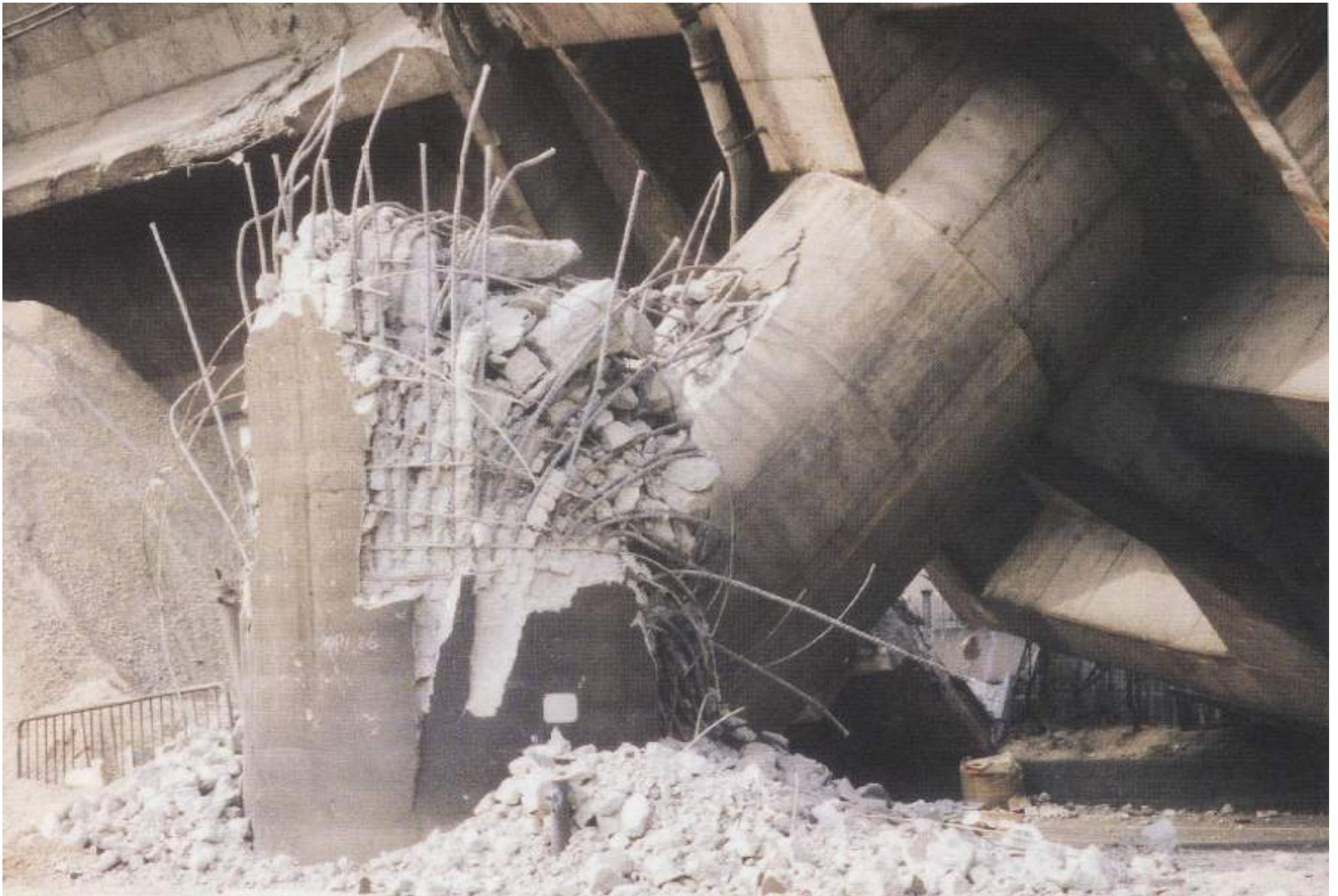
写真 阪神大震災で倒壊した高速道路橋脚のせん断破壊
