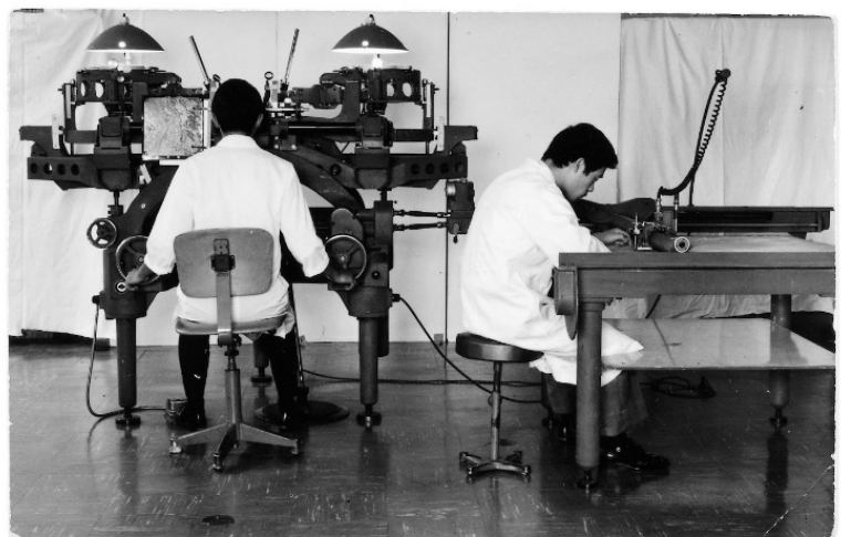
1956年当時、最先端だったステレオプロットイングマシンA8精密図化機 (東京大学生産技術研究所丸安研究室)
