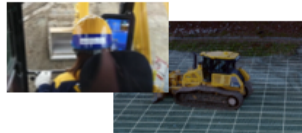
ICT建機による施工
