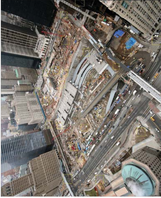
World Trade Center 施工現場の実写
