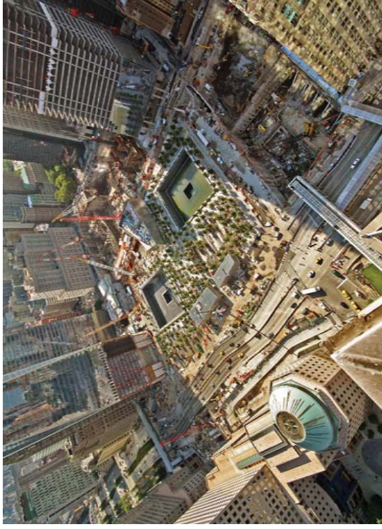
World Trade Center 施工現場の実写
