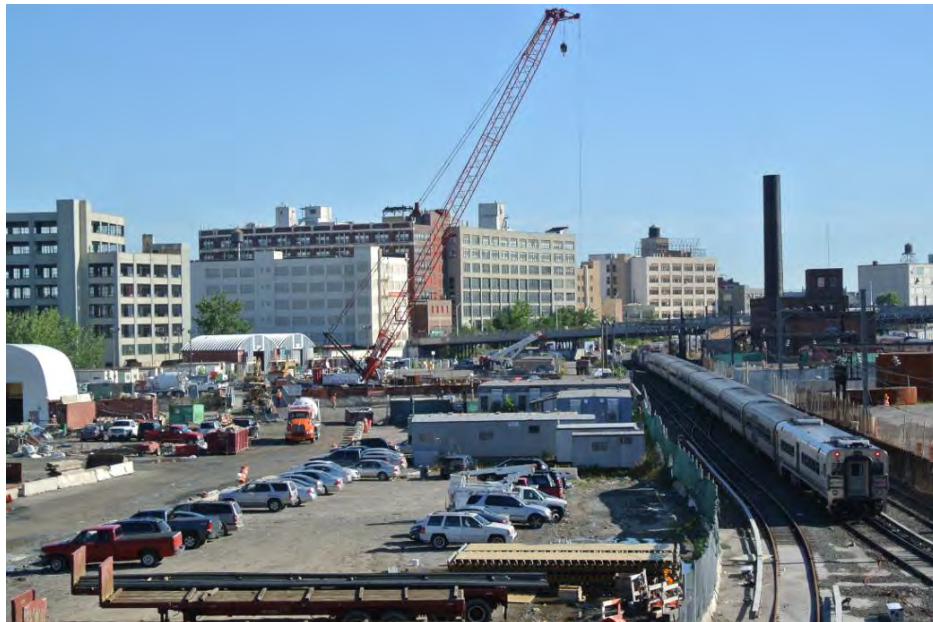
図 2-26 イーストサイドアクセス Queens 立坑建設現場
