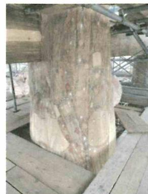
写真-3 親柱補修状況
