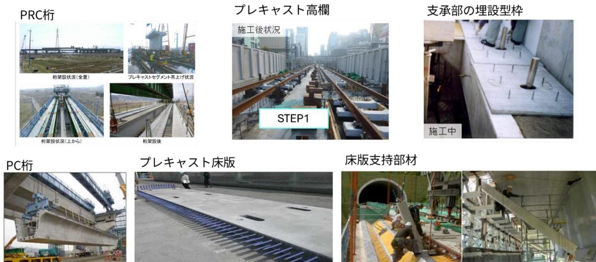
図 4.2-1 道路、鉄道におけるプレキャスト構造(部材)の採用例
