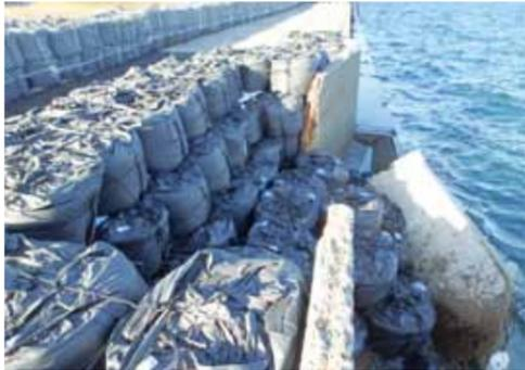
写真-9 L型擁壁倒壊箇所復旧完了
