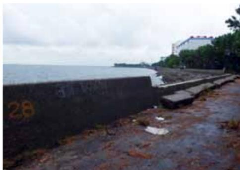
写真-4 護岸上部工倒壊状況
