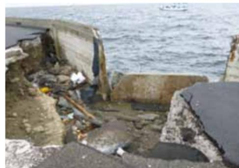
写真-1 L型擁壁倒壊・陥没状況
